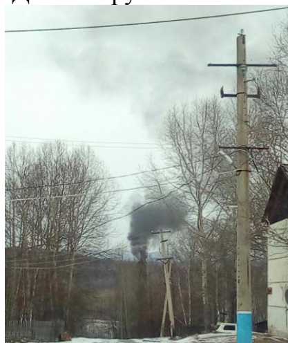
Дым из трубы котельной
